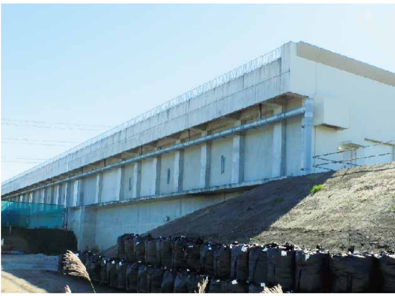
試運転が始まった江戸川第一終末処理場
