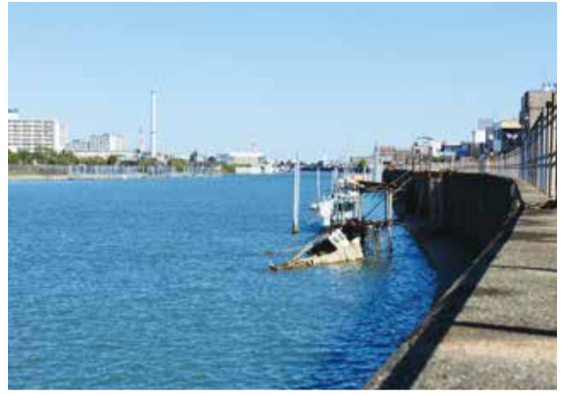
（仮称）押切橋の架橋が計画されている旧江戸川
